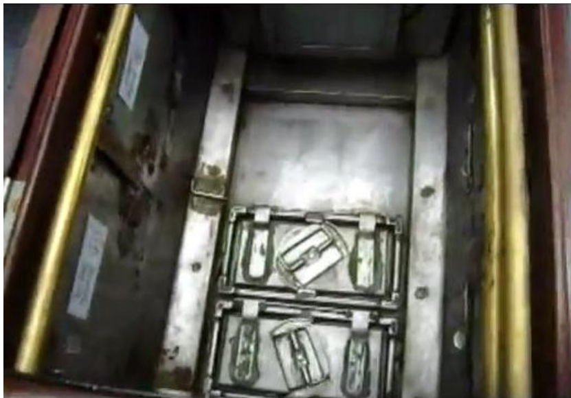
Visão do acesso aos tanques na parte interna.
