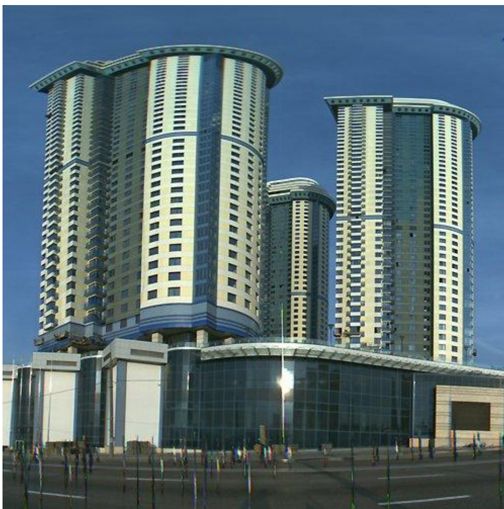
Objetiva Peleng. A câmera gira em torno de um eixo vertical. As paredes não concordam, mas as proporções das janelas dependem fortemente do andar em que estão.
